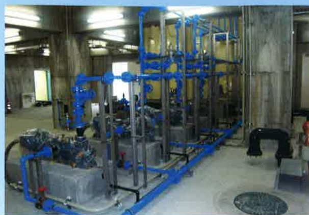
■配管工事 企業局 新石川浄水場
