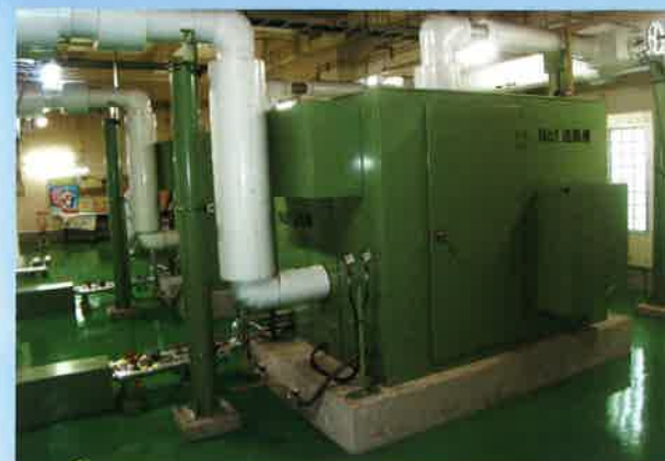
■機械据付 下水道事業団 うるま市終末処理場
